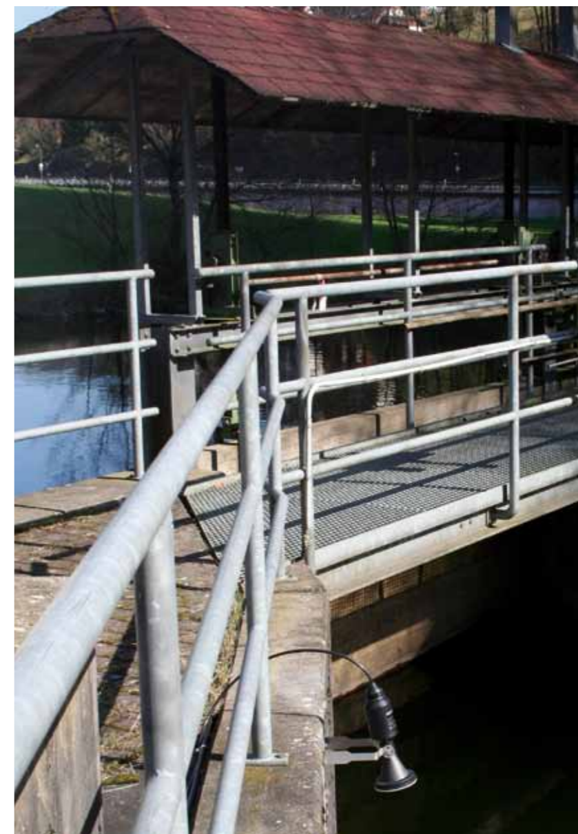
Installation ved å og vandløb.
