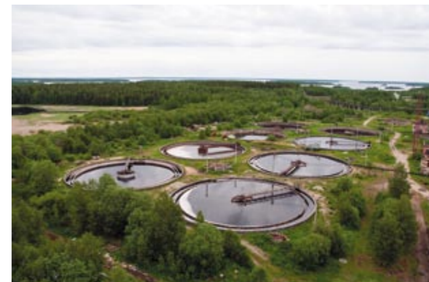
Rensningsanlæg i Tyskland
