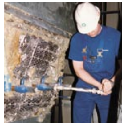
Montage af midlende pitotrør i kvadratisk kanal for primær luft.
