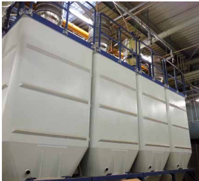
VEGAFLEX82 måler niveauet i de 3 meter høje siloer med høj nøjagtighed.
