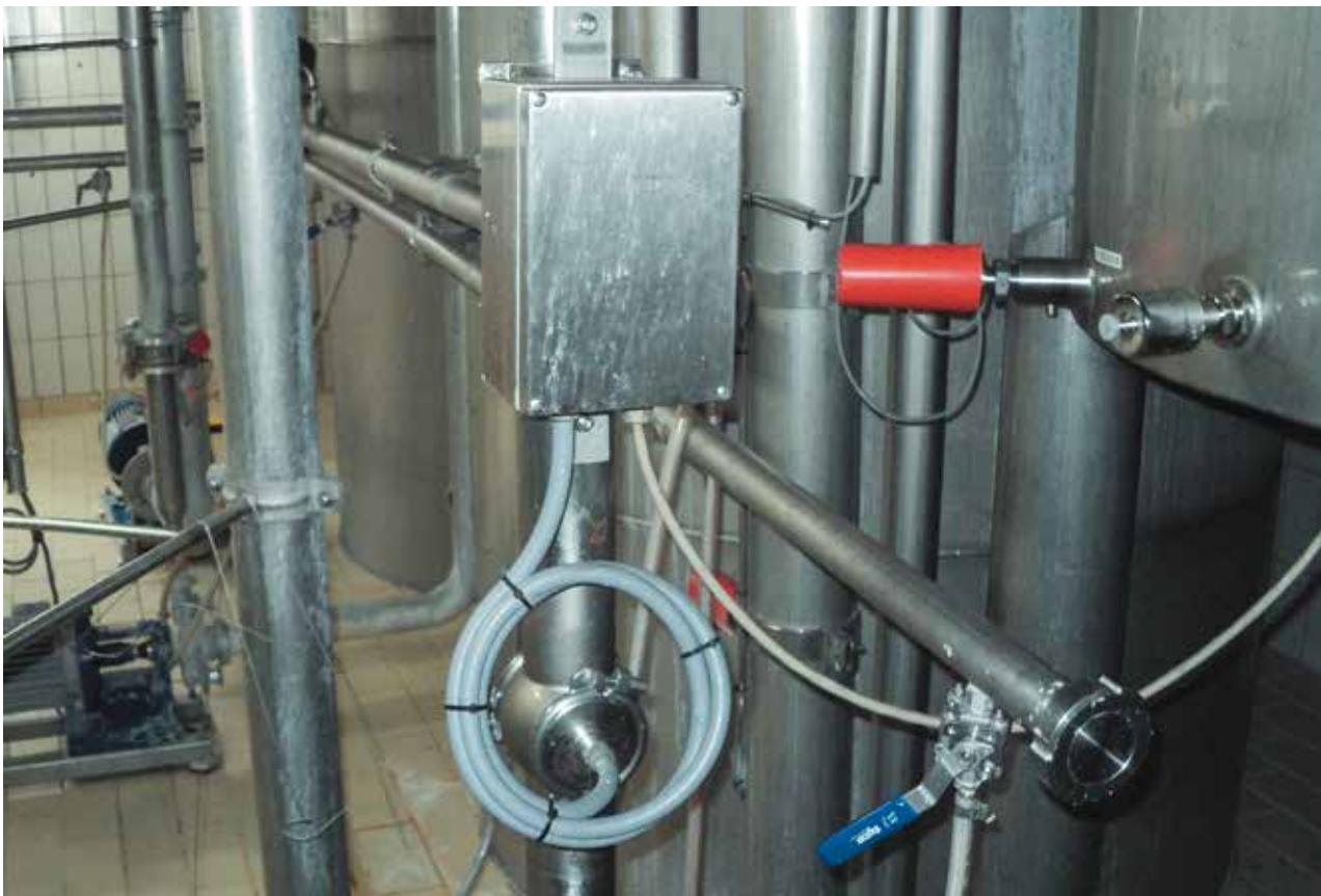
Fig 2. LiquiSonic sensor installeret i rørstrengen i forbindelse med fordamperen på FrieslandCampina.
